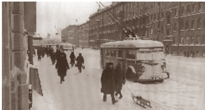
Невский пр. Остановившиеся из-за отсутствия электричества троллейбусы
