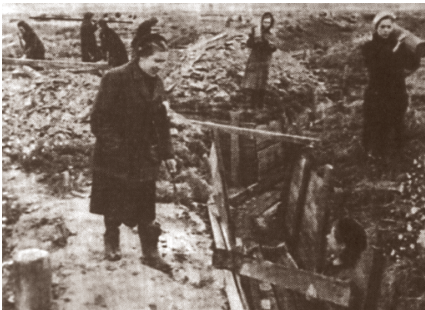
Школьники со взрослыми на строительстве оборонительных сооружений. 1941 г.
